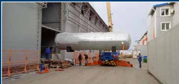
Циркуляционный ресивер для насосной подачи аммиака в приборы охлаждения
